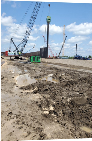
22-506 PLNG Sheet Piling
